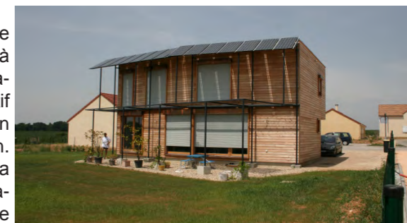
Façade sud de la maison
