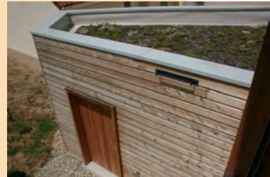
La toiture végétalisée
